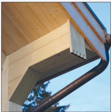
Ortrinne, Pfettenbrett mit Hohleisenschnitt
