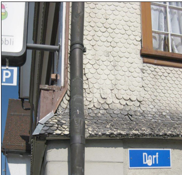
Schindelabwürfe mit Farbabplatzungen und Fäulnissschäden
