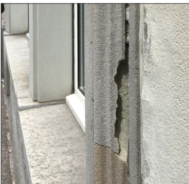
Fenstereinfassungen in Sandstein mit Erosionsspuren
