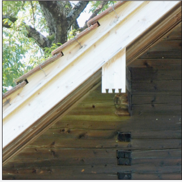
Ziegel eingesägt mit Sturmklammern, Pfettenbrett mit Schwalbenschwanzschnitt
